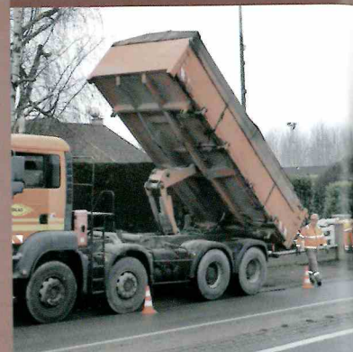
Réfection des trottoirs
