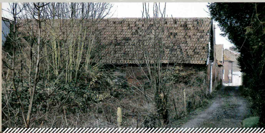
Zone qui sera en voie douce après un élargissement
